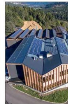
La centrale di teleriscaldamento
