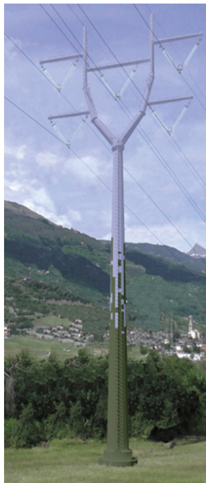
Figura 7 Sostegno “5 Fasi” monostelo con camouflage “digitale”
