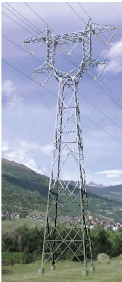
Figura 6 Sostegno “5 Fasi” a traliccio
