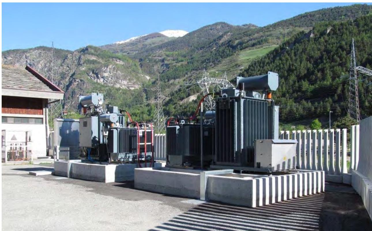
**Figura 25. Opere realizzate per la gestione a neutro compensato della rete sottesa alla CP VILLENEUVE.**
