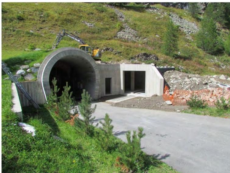
**Figura 29. Lavori edili eseguiti presso la centrale Thumel (si evidenzia come la nuova costruzione risulti interrata al fine di rispettare le richieste di integrazione paesaggistica).**
