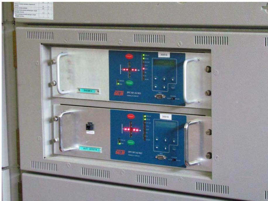
**Figura 27. Nuovi pannelli di linea MT (feeder RHEMES) SELTA SPC901-A2-NCI installati in CP.**
