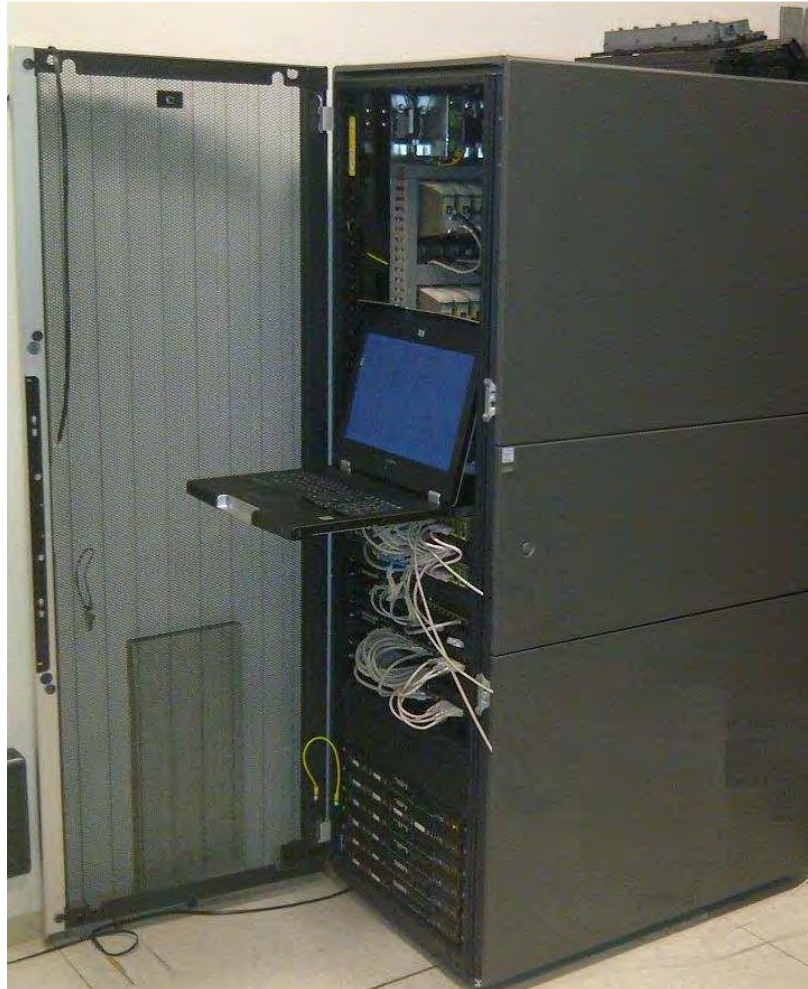
Figura 2.1-3 – Nuovo Sistema SCADA
