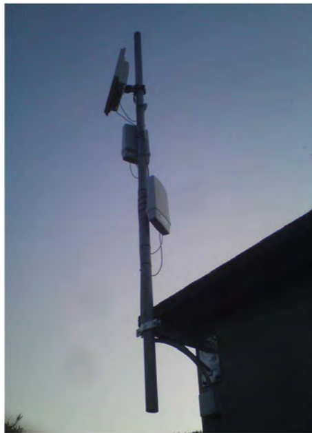
Figura 45: particolare di un'antenna Hiperlan
