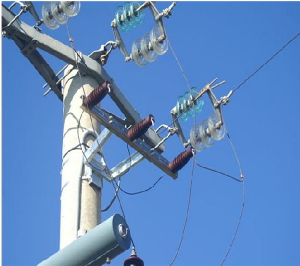
Figura 73-Installazione in campo dei rilevatori dei punti di innesci
