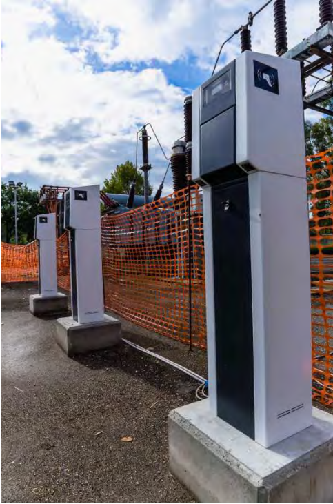
Figura 59 - Colonnine di ricarica "lenta"
