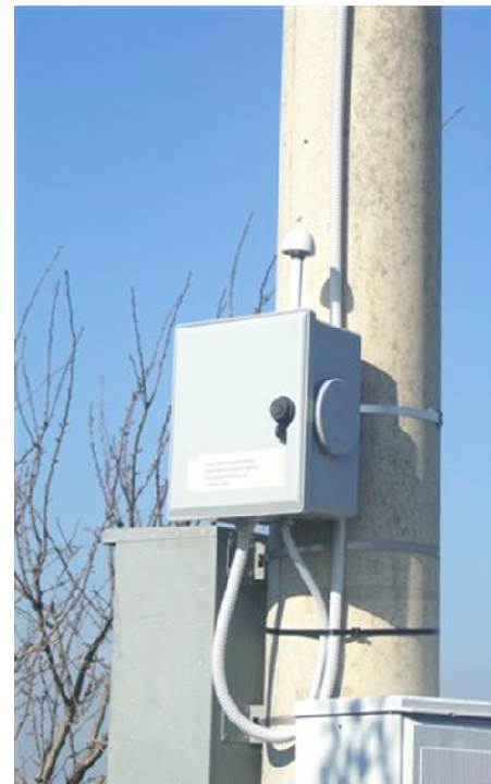
Figura 73-Installazione in campo dei rilevatori dei punti di innesci
