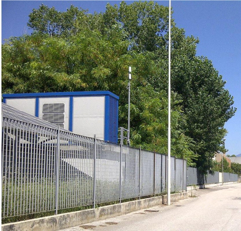
Figura 1.24 – Antenna del nuovo sistema di comunicazione installata presso l'impianto pilota numero 5
