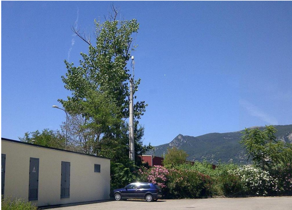
Figura 1.26 – Antenna del nuovo sistema di comunicazione installata presso l’impianto pilota numero 1
