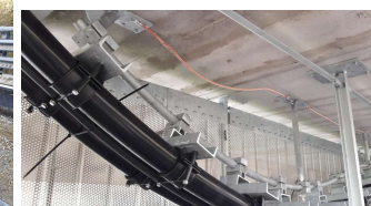
Transizione cavo da interno/esterno cassone su viadotto Borgone
